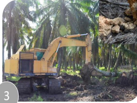
Excavation at 1.5 - 2.0 m (L) x 1.5-2.0 m (W) x 1-1.5 m (D) for 2-3 months
